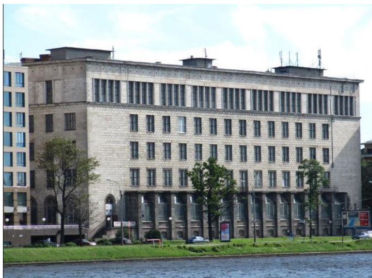
Рис. 4. Дом художников на песочной набережной, архитектор Лапиров А.И., Санкт-Петербург, 1961–1963 гг.
